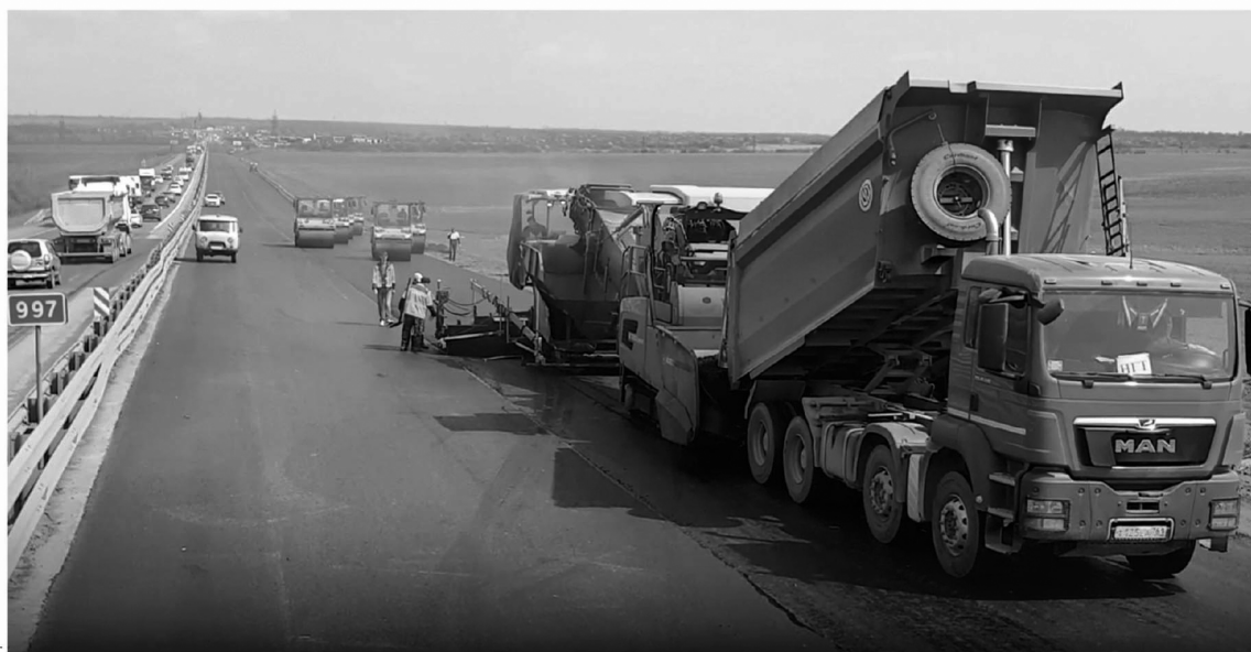
Работы на трассе уже начались
